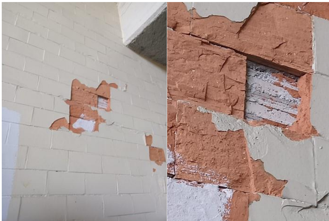
Figura 1. Edificio A. Daños existentes en cubo de escaleras. Desprendimiento parcial del recubrimiento (fachaletas) de muros.
