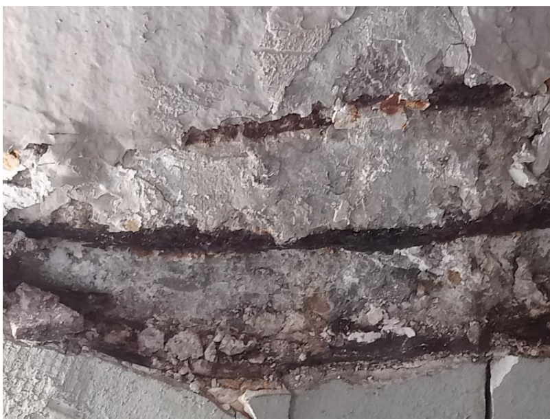
Figura 3. Edificio A. Confinamiento de acero expuesto en base de columna con alto grado de oxidación y corrosión.
