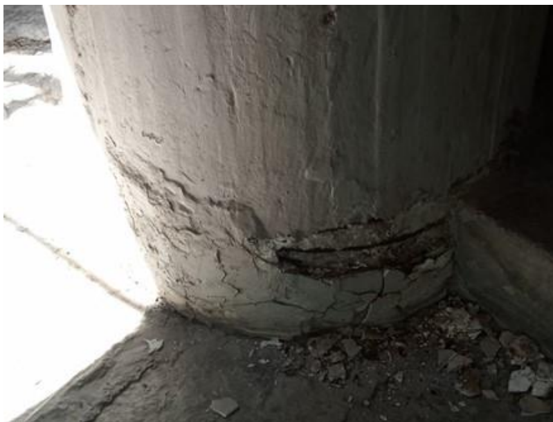
Figura 2. Daño en base de columna. Fractura y desprendimiento de resane, previamente perdió recubrimiento
