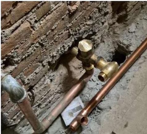
Instalación de fluxómetro de pedal en el ducto de instalaciones
