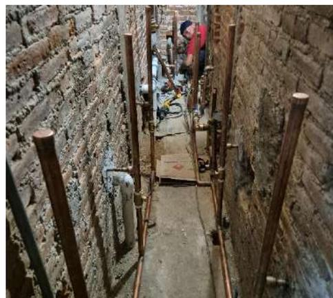
Tubería nueva terminada para la alimentación a los muebles sanitarios
