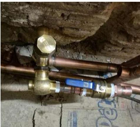
Detalle de instalación. Válvula de control por cada mueble sanitario
