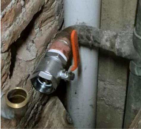
Válvula de 2 Pulg nueva e instalada
