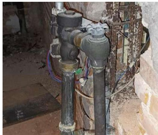
Cableado de fluxómetros en malas condiciones y expuesto
