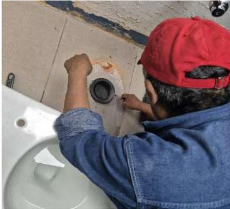
Desmontaje de WC y sustitución de sello de cera por brida flexibles
