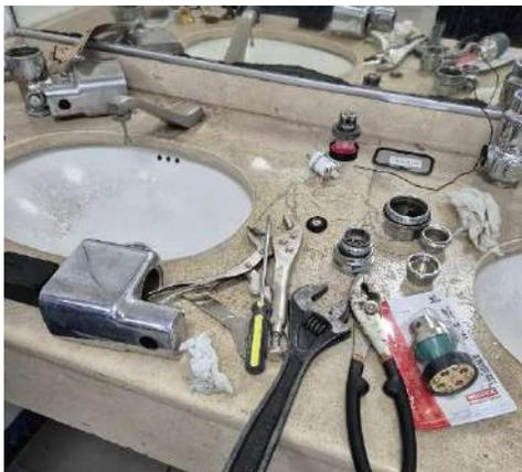
Desarmado, limpieza, sustitución por refacciones nuevas de elementos de fluxómetros
