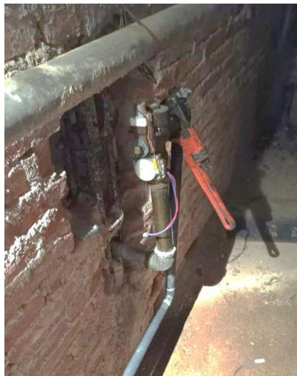
Desconexión de tubería de alimentación a fluxómetro TOTO
